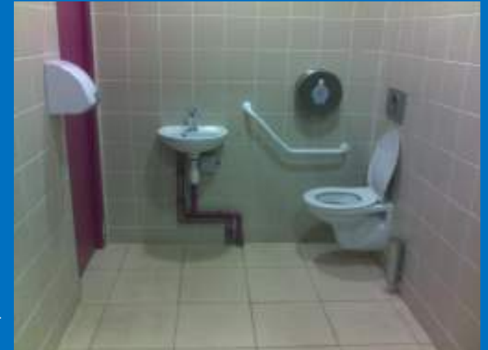
16) Illustration d'un cabinet d'aisances aménagé selon les caractéristiques réglementaires
