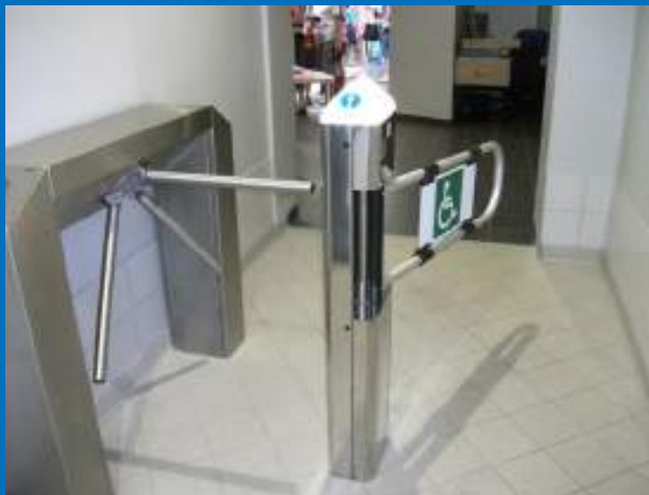
12) Illustration d'un dispositif permettant aux personnes en fauteuil de contourner le tourniquet (tripode).
