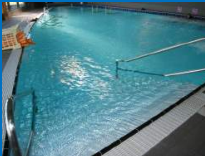
27) Illustration d'un escalier d'accès à l'eau avec une double main-courante de chaque côté
